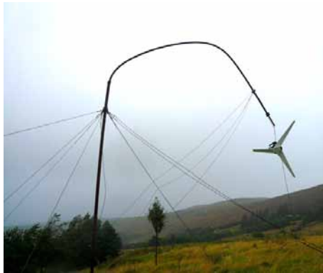
Fig. 58: Broken guy wires
